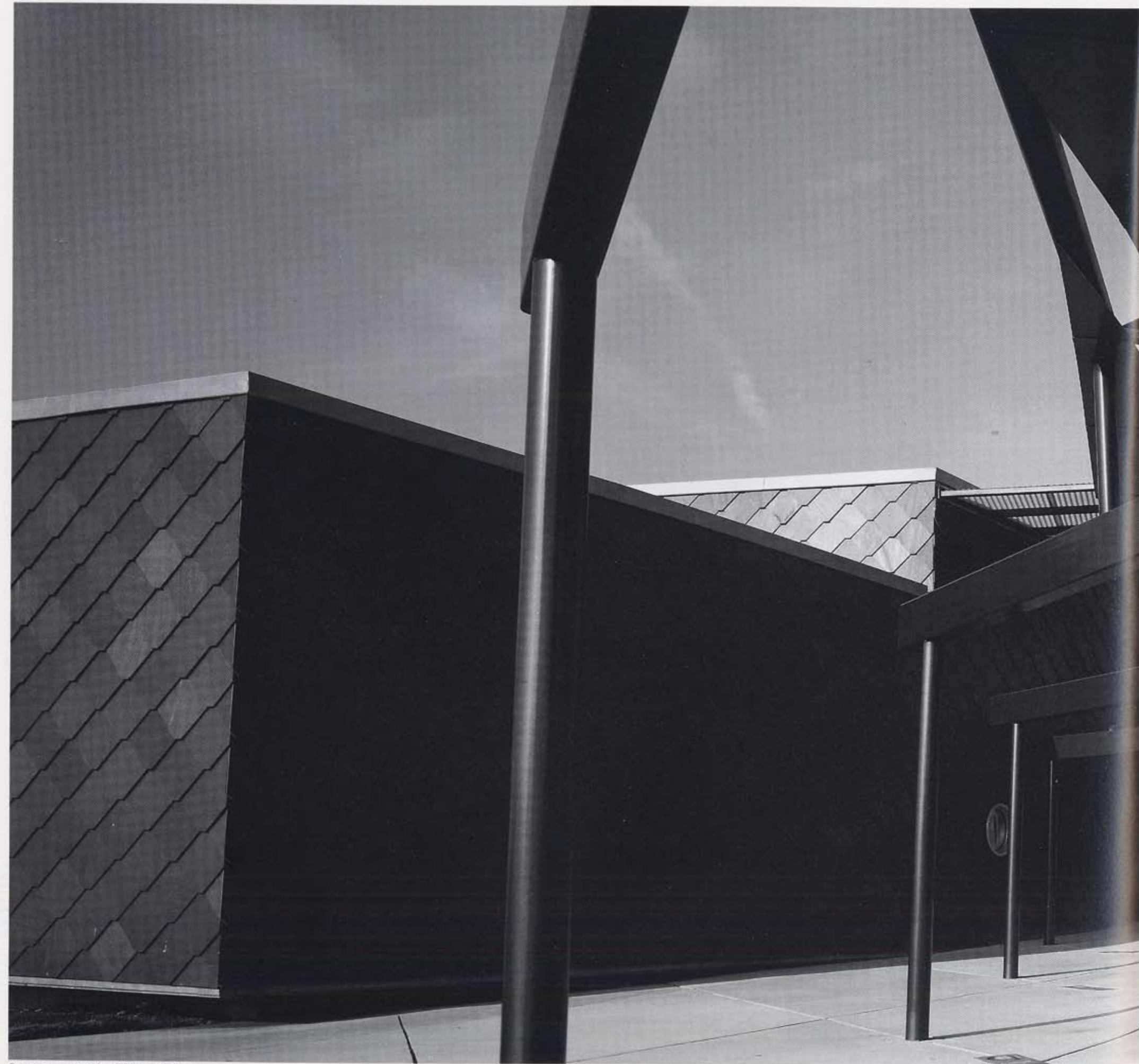
Canopy on north side 北側キャノピー
