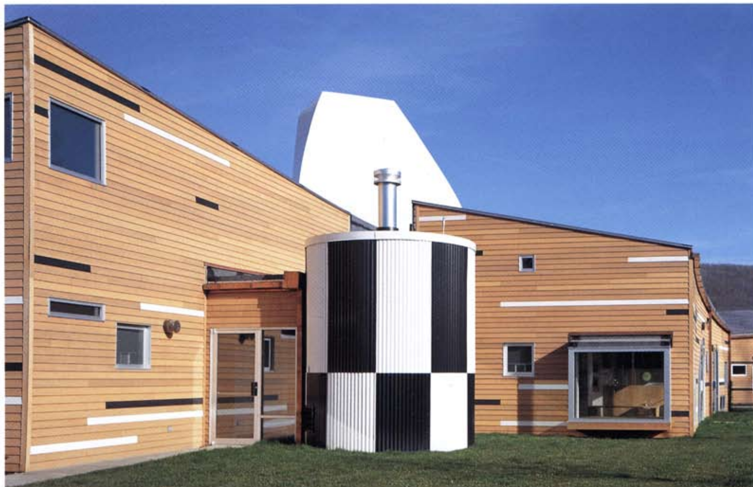
Boiler room ボイラー室
